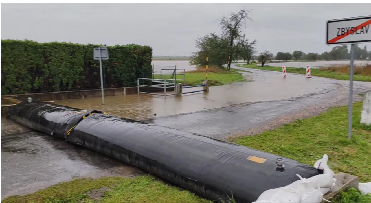
Příprava pro instalaci vaků na místní komunikaci Zbyslav – Výčapy a instalované vaky při povodni v září 2024.
