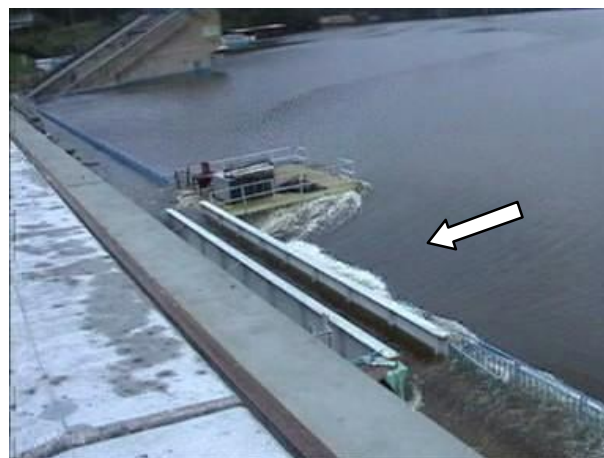
Obr. 2 Snímek povodňové situace na přelivech VD Orlík ze srpna 2002
